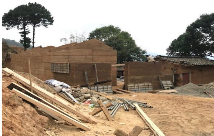
28/04/2019 主房主體施工完畢
